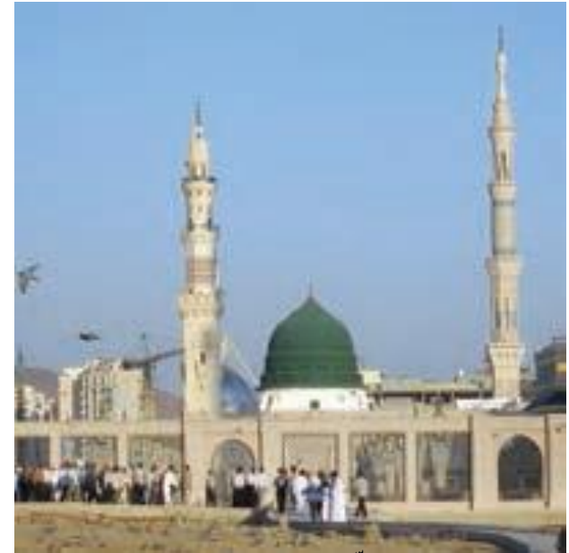
مسجد النبی، نمای بیرونی
