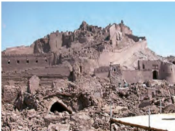
ارگ بم، بزرگ‌ترین سازه خشتی جهان در زلزله بم دچار تخریب زیاد شد.
