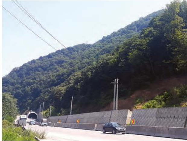
نصب حفاظ بتونی - جاده قائم‌شهر
