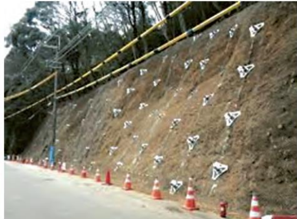
پایدارسازی دامنه به روش شمع کوبی با استفاده از میل‌گرد فولادی، بستن مهره و تزریق سیمان
