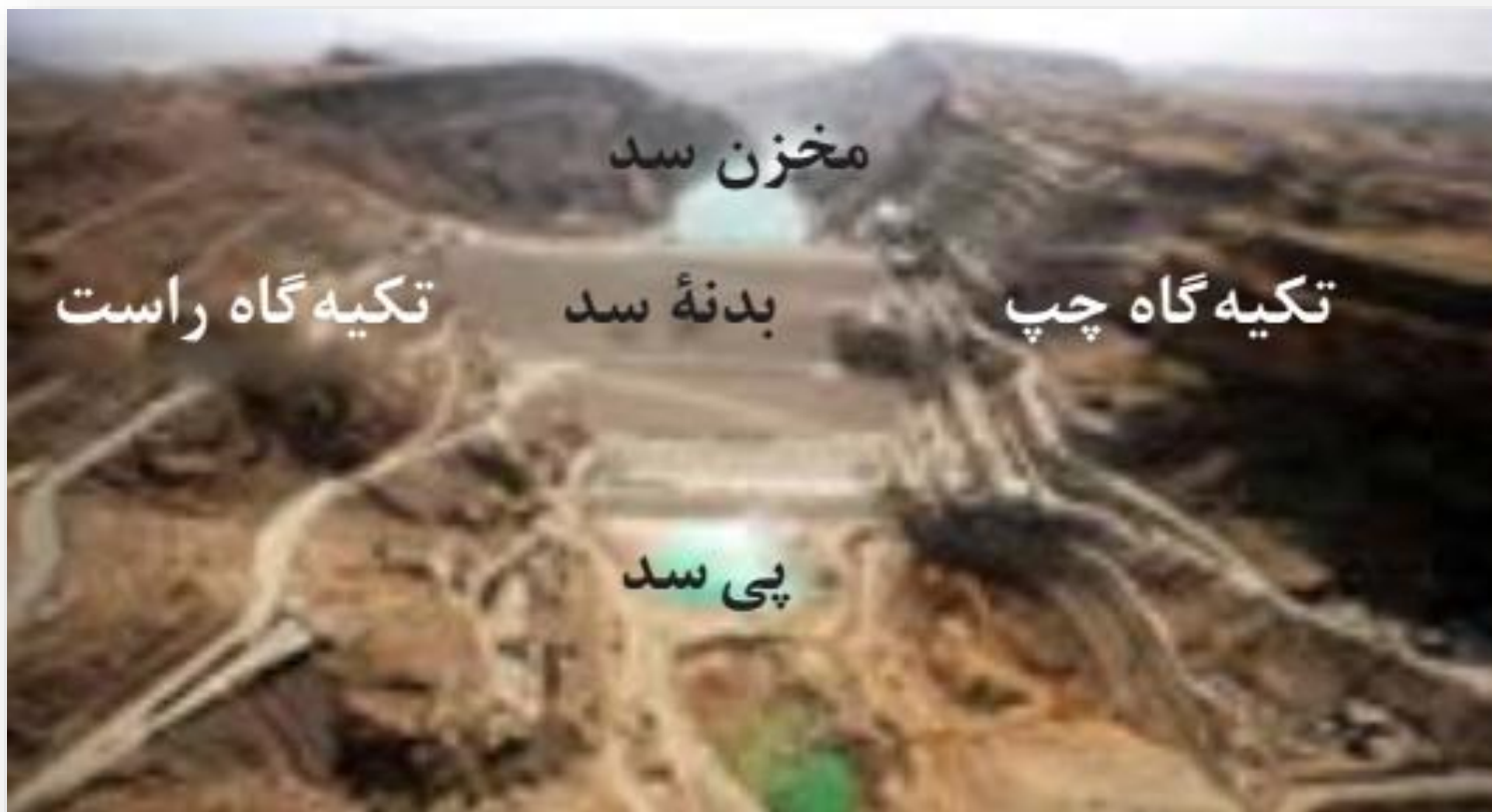
شکل ۴-۵: نمایی از بخش‌های مختلف یک سد
