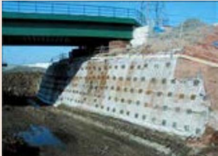
پایدارسازی شیب به روش میخ کوبی
