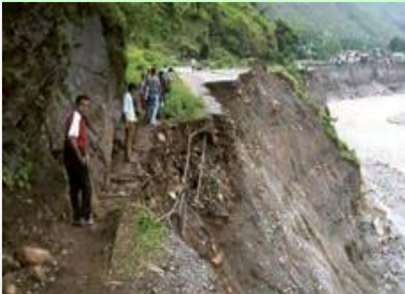
لغزش در اثر زیر بری رودخانه در هند
