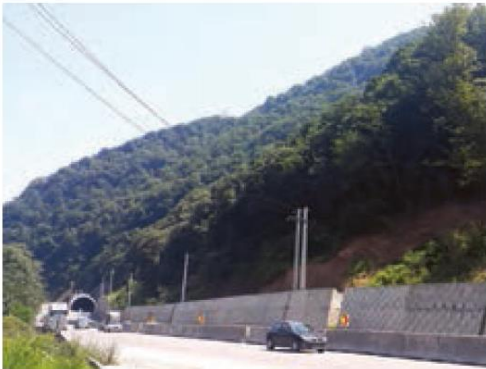
نصب حفاظ بتونی - جاده قائم شهر
