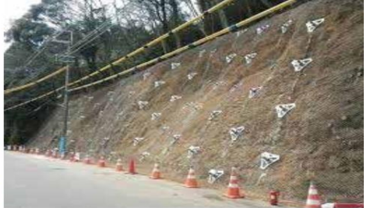
پایدار سازی دامنه به روش شمع کوبی با استفاده از میل گرد فولادی، بستن مهره و تزریق سیمان
