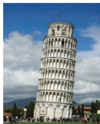
شکل ۱-۶ نشست نامتقارن پی در برج پیزا
