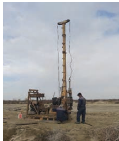
شکل ۳-۶ حفاری گمانه اکتشافی توسط دستگاه حفاری
