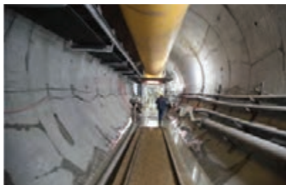
ب) پوشش های بتنی در مترو
