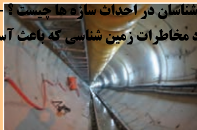
تونل انتقال آب (تونل کانی سیب - پیرانشهر)
