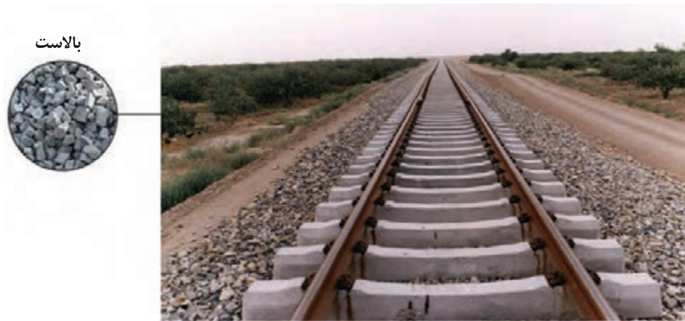
شکل ۲۳-۶- بالاست استفاده شده در زیرسازی جاده ریلی
