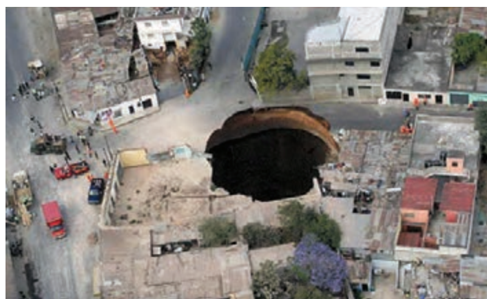
شکل ۲-۶ حفرات کارستی بزرگ ایجاد شده در مناطق شهری
