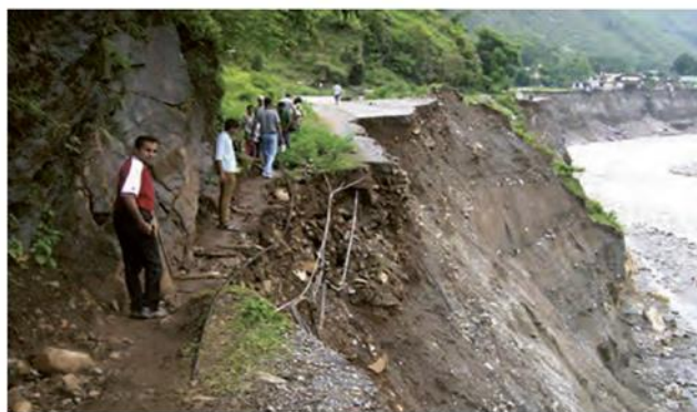
لغزش در اثر زیربُری رودخانه در هند
