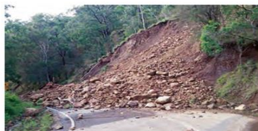
زیربُری دامنه برای ساخت جاده و وقوع لغزش
